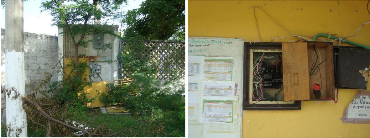
*Imagen 8. Cableado en malas condiciones*
